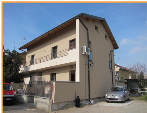
Villetta privata in loc. Limbiate ( MI ) Rifacimento completo copertura e coibentazione murature con cappotto termico.
