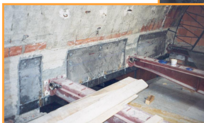
Rinforzo travi copertura stazione Stazione Ferrovie Nord Milano Cadorna
