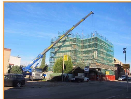
Condominio in loc. Varedo ( MI ) Rifacimento completo facciate e copertura
