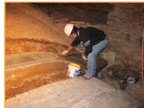
Chiesa Sant ' Antonio Martire Lozza ( VA ) Rinforzo archi navata con materiali compositi.
