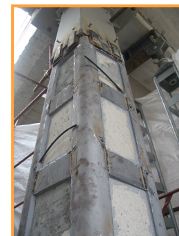
Stazione Ferrovie Nord Castellanza Rinforzo strutturale pilastri di sostegno pensilina eseguiti con tecnica mista Beton Plaquet e tessuti in Fibra di Carbonio.
