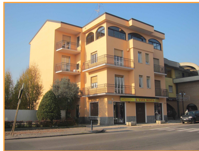
Condominio in loc. Varedo ( MI ) Rifacimento completo facciate e manto di copertura
