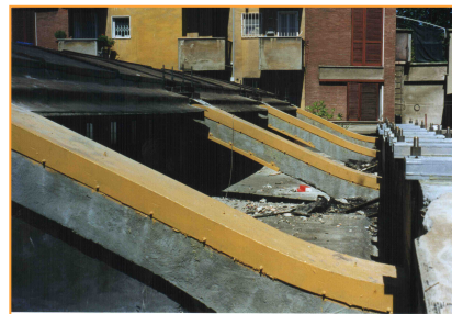
STATIC Via Domodossola Milano Rinforzo strutturale intero fabbricato e realizzazione di un soppalco di 150 mq Interamente appeso con barre Dywidag.
