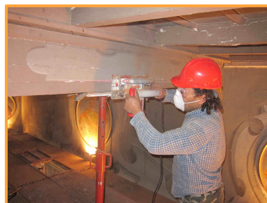
Chiesa San Giovanni Evangelista - Rodano ( MI ) Rinforzo capriate in legno con FRP
