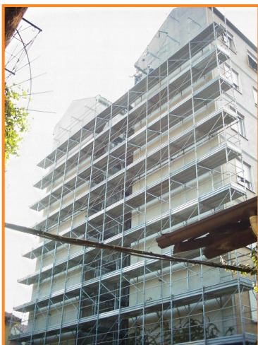
Condominio De Amicis – Meda ( MB ) Rifacimento completo manto di copertura con rimozione amianto
